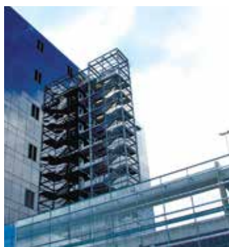
Tallinna Delta Plaza autoparkla fassaad
